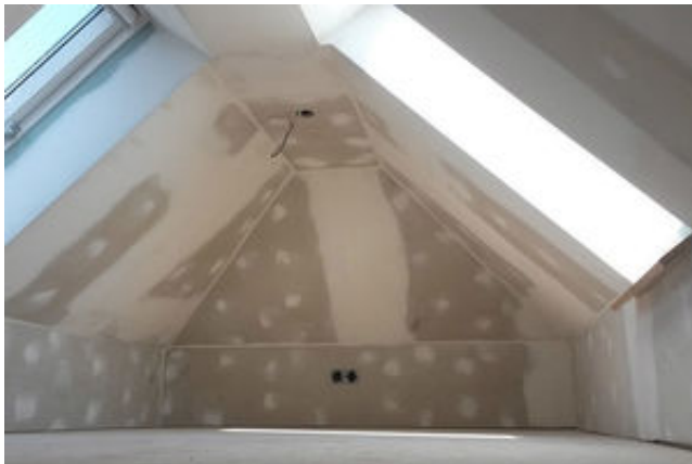
Trockenbau Dach
